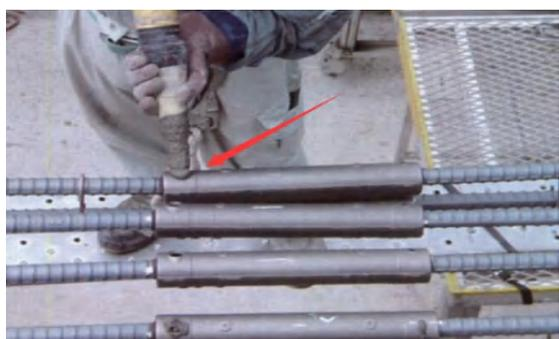
灌浆料用于钢筋套筒连接
