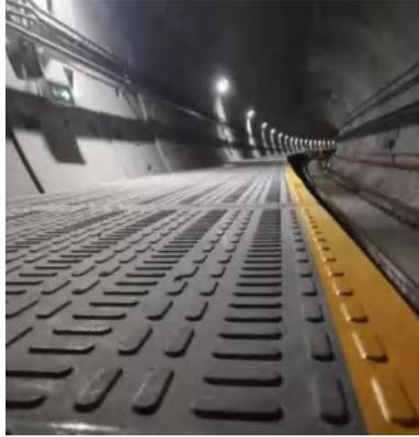
地铁隧道疏散平台板
