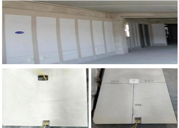
管线一体化砂加气混凝土板及工程应用
